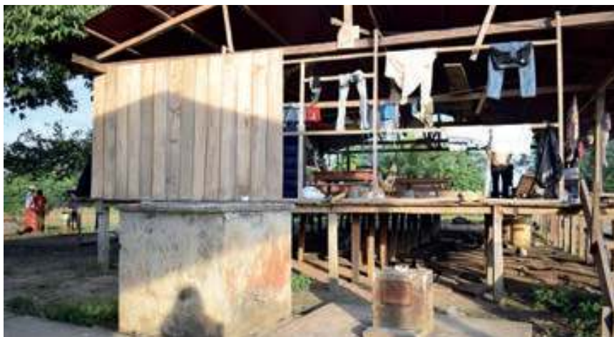
Foto n.º 21 Se observa los vestigios del pozo de agua y tanque de agua construidos por Water for Life Proyect
